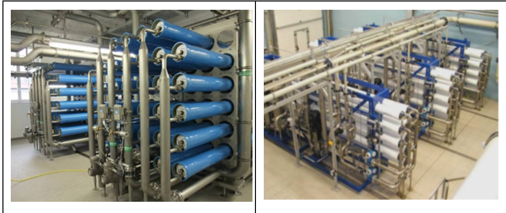
Figur 3.9 Billede af LPRO membraner til blødgøring.
